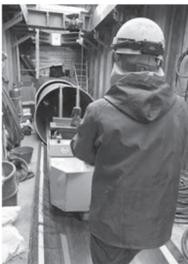
鋼管の既設管への挿入状況
