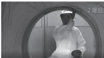
現場溶接部塗装の試験施工
