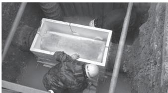
布設替えや切り回しのための一時的な止水に最適 凍結工法 450A
