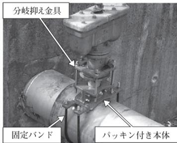
写真1. 構成材料 (本管400mm×分岐75mm)
